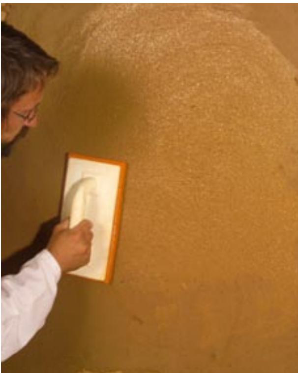
Abbildung 6.1.7: Oberflächenbearbeitung von Lehm-Oberputz grob durch Reiben mit dem Schwamm Brett
