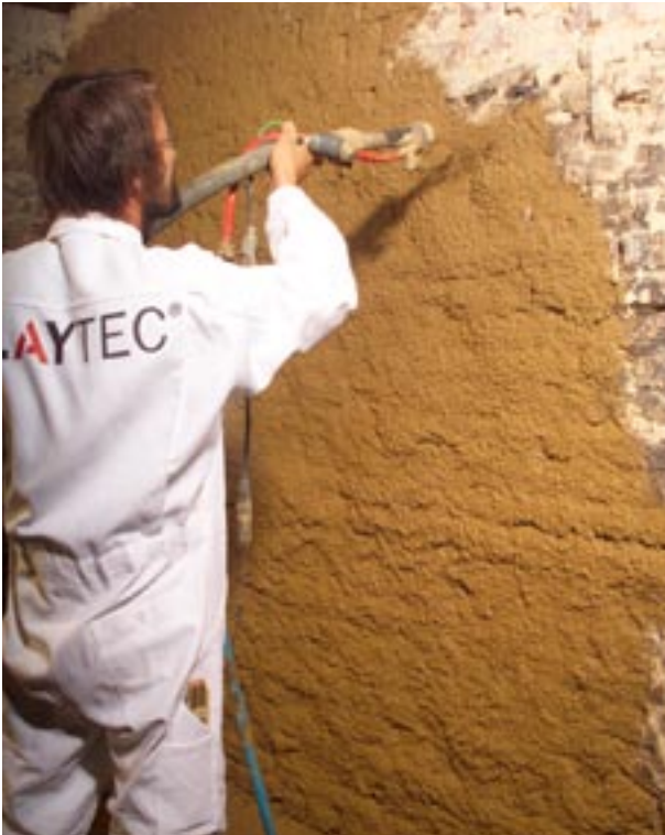
Abbildung 6.1.1: Anspritzen von Lehm-Unterputz auf Ziegelmauerwerk mit der Putzmaschine
