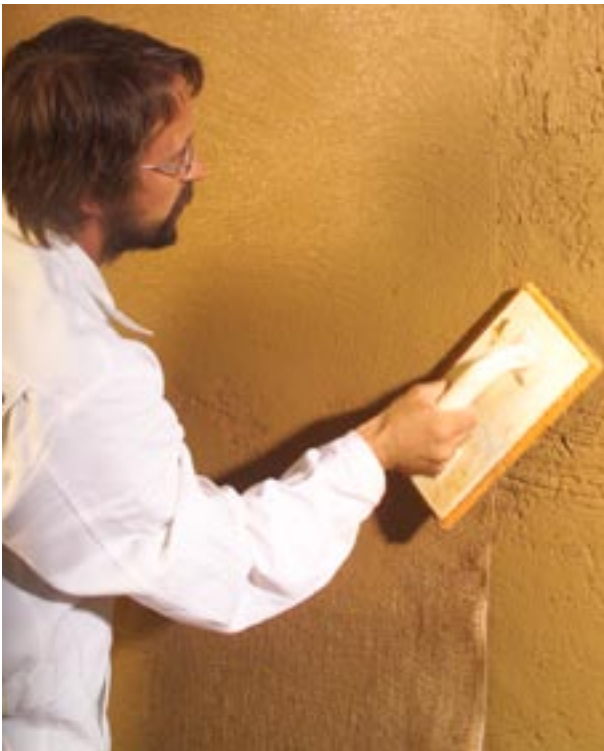
Abbildung 6.1.3: Einarbeiten der Armierung , hier Jute , mit dem Schwamm Brett (nicht bei Ziegelmauerwerk, Anwendung s. Tabelle Seite 5)
