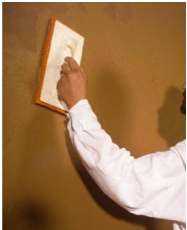
Abbildung 6.1.8: Oberflächenbearbeitung von Lehm-Oberputz fein durch Reiben mit dem Schwamm Brett
