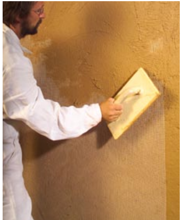
Abbildung 6.1.4: Einarbeiten der Armierung, hier Glas-Seidengewebe , mit dem Schwamm Brett (nicht bei Ziegelmauerwerk, Anwendung s. Tabelle Seite 5)
