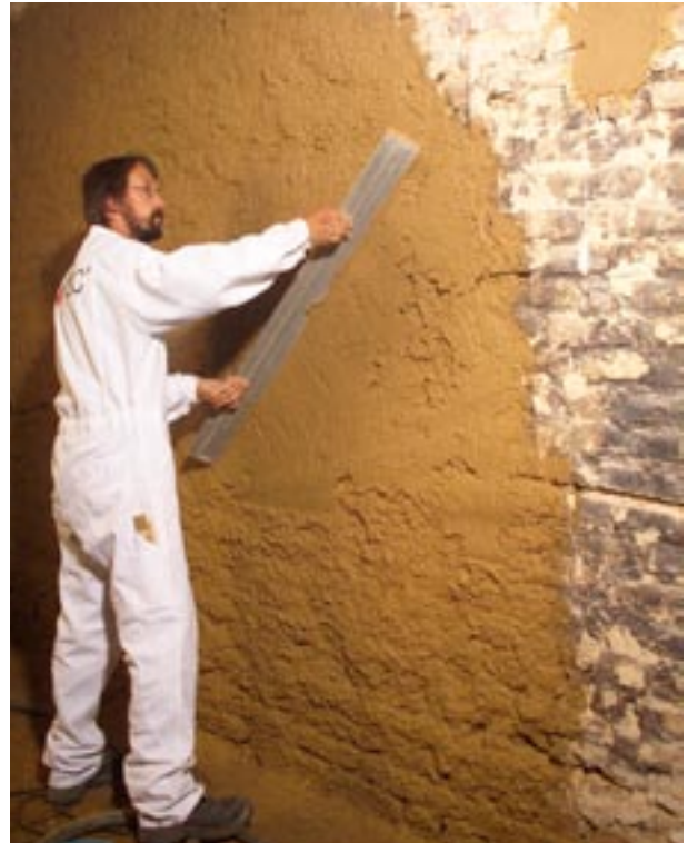
Abbildung 6.1.2: Grobes Abziehen der frischen Putzfläche mit dem Aluminium-Richtscheit
