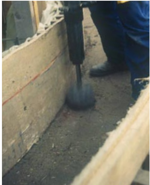
Abb. 1.1.2: Nachstampfen der Randbereiche mit dem pneumatischen Stampfer, geeignet auch für dünne Wände.
