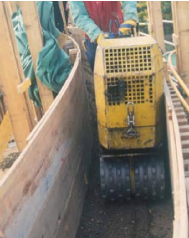
Abb. 1.1.1: Wirtschaftliches Verdichten des Wandkern-Bereiches mit der Schafffußwalze.
