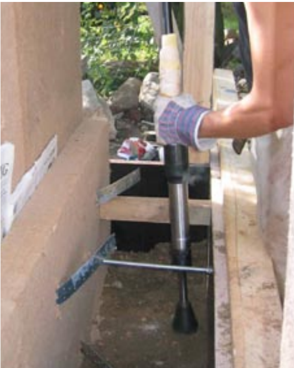
Abbildung 1.1.3: Der Kleinstampfer ermöglicht auch das sorgfältige Verstampfen kleinräumiger Bauteilbereiche.
