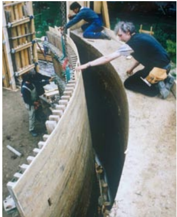
Abb. 1.1.4: Entfernen der Schalungswand unmittelbar nach Ende der Stampfarbeiten
